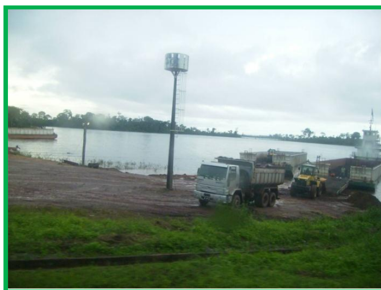
FIGURA 55: Navegação de Balsas no reservatório e terminal de desembarque de produtos – transporte de cargas.
