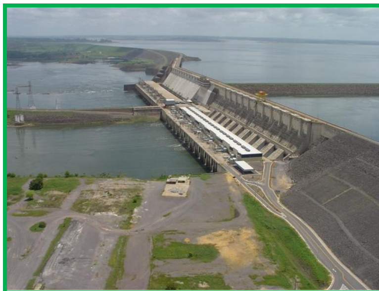
FIGURA 51: Geração de Energia – Usina Hidrelétrica de Tucuruí
