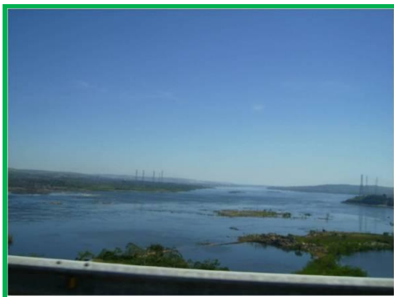
FIGURA 6 – Rio Tocantins à jusante da barragem de Tucuruí.
