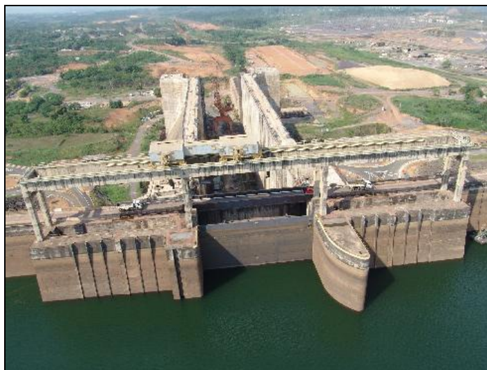
FIGURA 64: Sistema de transposição de desnível d'água.
